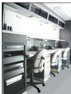
Plataforma de operaciones
