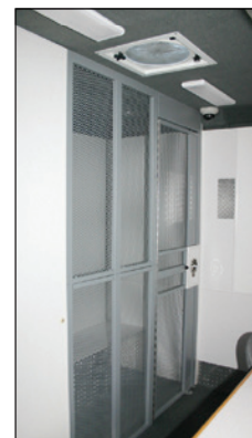
Celda de contención con visibilidad total.
