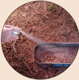
PASO 1: Aplique el endurecedor de tierra y polvo (No. 638CA)*.
