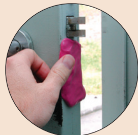
4. Presione el compuesto sobre la impresión. Retírelo después de 8 a 12 minutos.
